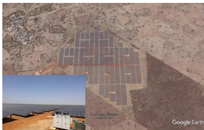
Malicounda 22 MW PV, região Thiès. Fonte: Google Earth
