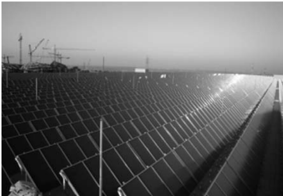
FIGURE 5. VUE D'ENSEMBLE DU CHAMP DE PANNEAUX SOLAIRES THERMIQUES MONTÉ SUR LE TOIT DE 36 305 M 2 D'UN IMMENSE HANGAR (SOURCE: MILLENNIUM ENERGY INDUSTRIES)
