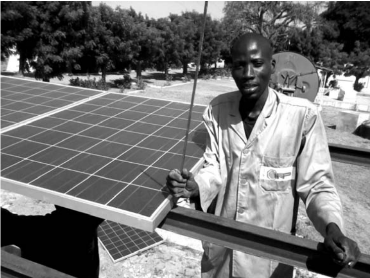
IMAGE 10. TECHNICIEN DE LA SOCIÉTÉ D'INSTALLATION LOCALE TRAVAILLANT SUR L'UNITÉ DE 3 KWC AU CÉRER. NOVEMBRE 2012
