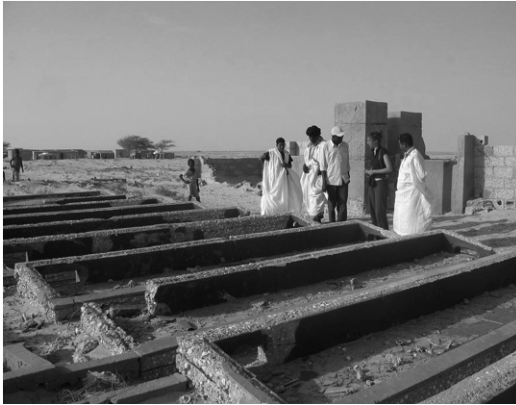
FIGURE. BALAWACK – EXEMPLE D'UN DISTILLATEUR SOLAIRE ABANDONNÉ (MAURITANIE)
