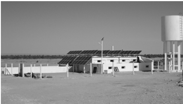
IMAGE 3. UNITÉ DE DESSALEMENT PHOTOVOLTAÏQUE DE KSAR GHILÈNE (SOURCE: ITC)
