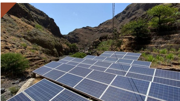
CAPE VERDE (SANTO ANTAO) Réhabilitation du réseau électrique hybride de Ribeira
