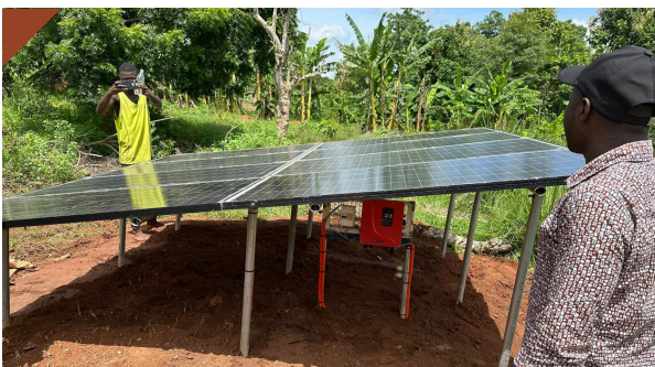
BENIM - Sistema de irrigação alimentado por energia solar (SPIS) instalado na Escola Secundária Técnica Agrícola de Adja-Ouèrè
