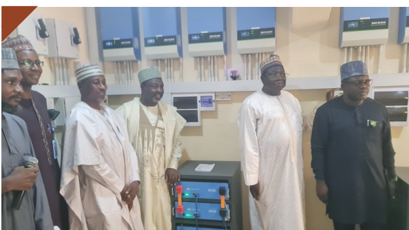
NIGÉRIA - Instalação de energia solar na Universidade Bayero, Kano
