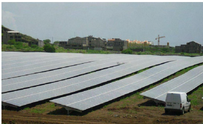
Estação solar de 5 MW ligado à rede, na Praia, Cabo Verde: A maior instalação de corrente em África subsaariana
