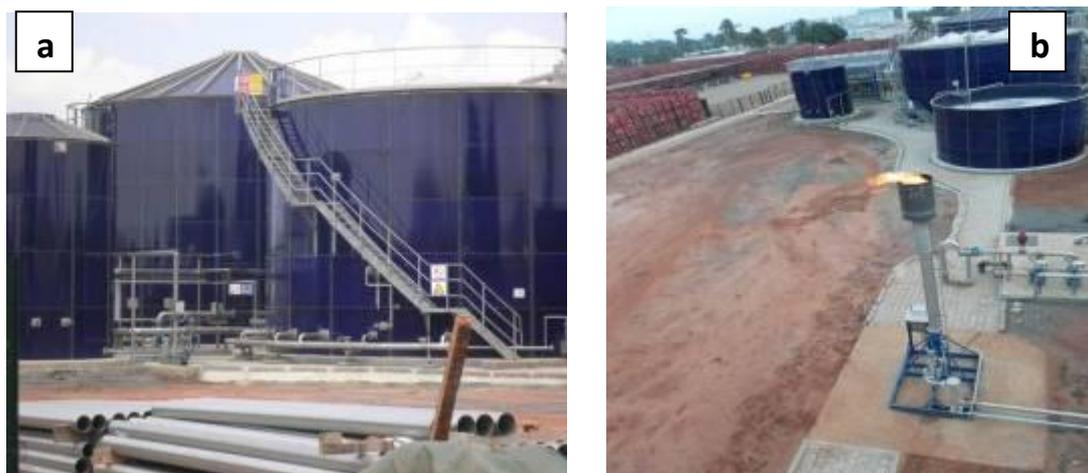
Figure 17 : Installation de méthanisation à la brasserie BB de Lomé (a) et élimination du méthane en torchère (b)
